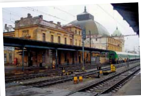
Nebezpečné úrovnňové přechody z plzeňského (hlavního) nádraží míří.
