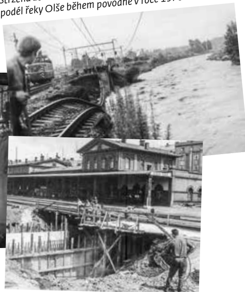
Výstavba podchodu v rámci úprav těšínského nádraží v letech 1962 a 1963
