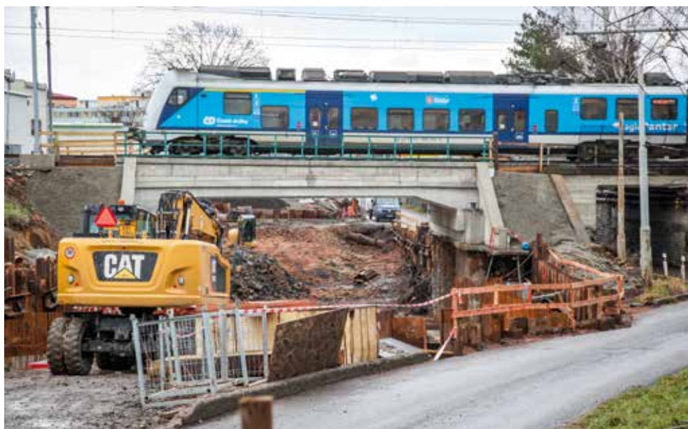
Bývalý přejezd v teplické ulici Emílie Dvořákové je aktuálně předěláván na podjezd. Vpravo bývalý tramvajový a nyní trolejbusový podjezd řízený světelnou signalizací, který bude naopak zrušen.
