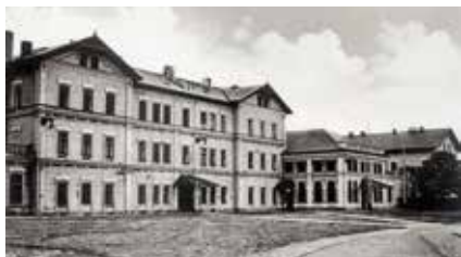
Staré nádraží v Mostě
