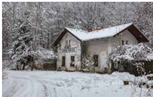
Bývalé nádraží Horní Prysk uprostřed lesů
