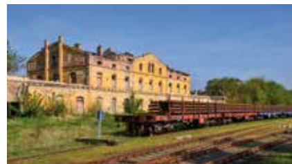
Bývalé nádraží v Duchcově před demolicí
