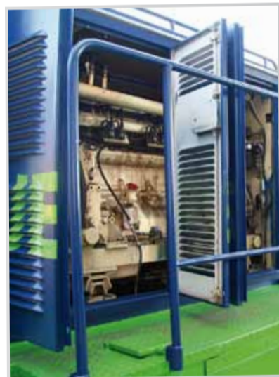
Pohon zajišťují dva motory TEDOM, každý o výkonu 260 kW.
