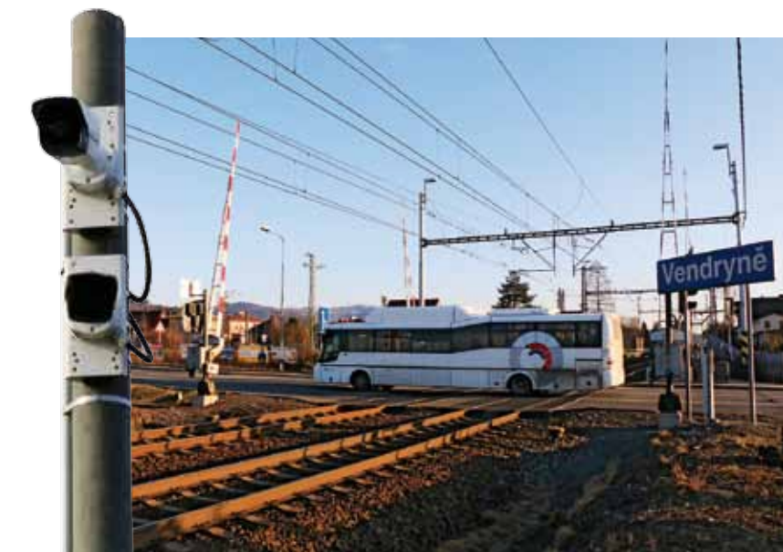
Nově střežený železniční přejezd ve Vendryni
