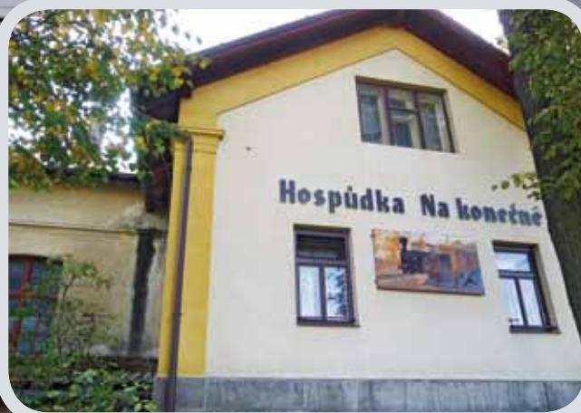
Objekt bývalého lokomotivního depa se proměnil v osvěžovnu pro lidi.
