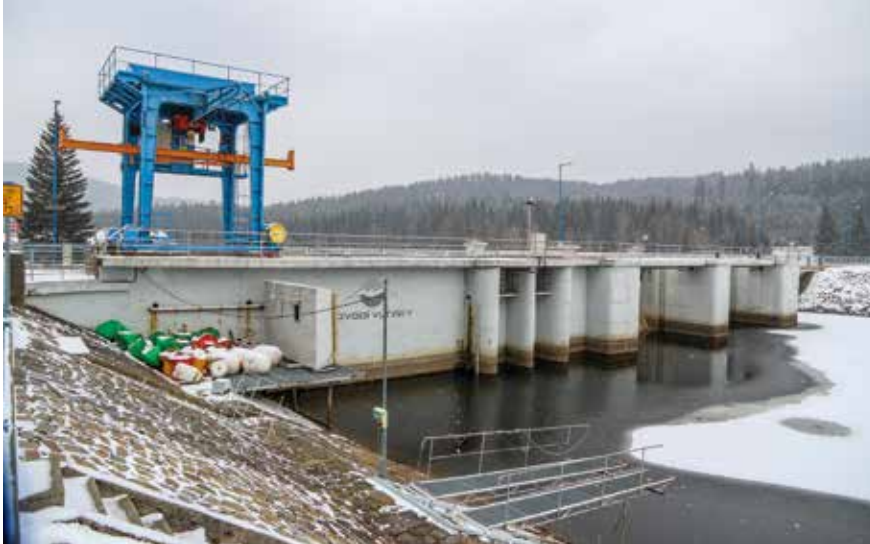
← Vodní dílo Lipno z první poloviny padesátých let. Vlevo na hrázi jsou vidět dva přepady
