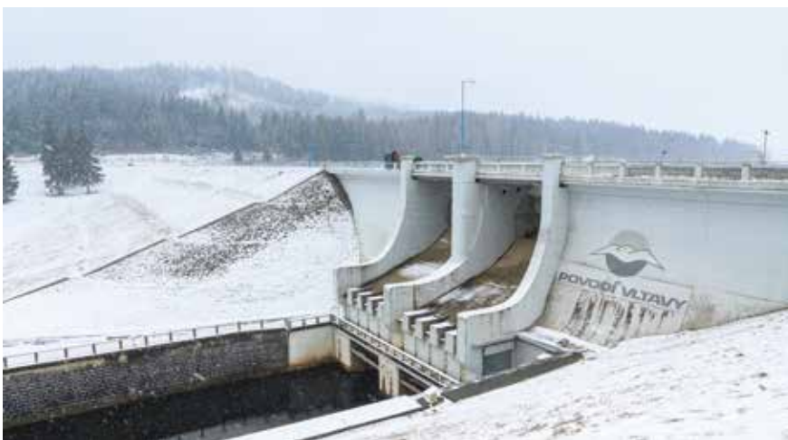
← Hráz přehrady je sypaná, s těsnícím jádrem. Výška činí 25 metrů, délka 296 metrů
