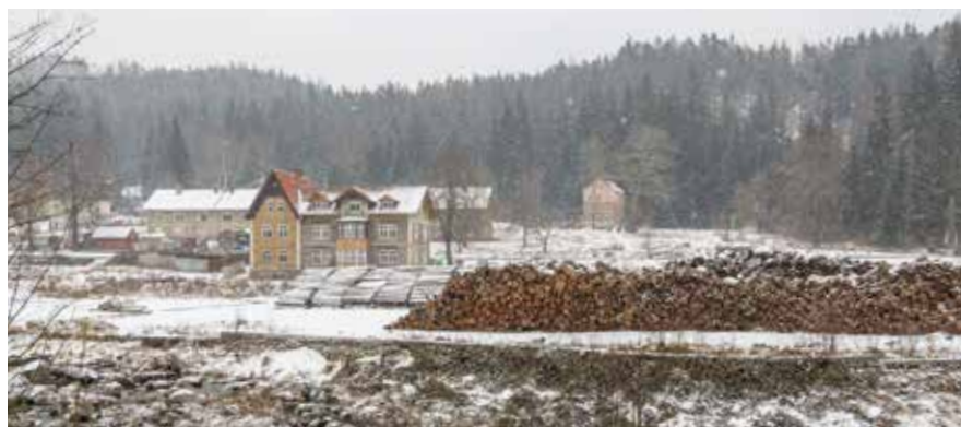
Z loučovické papírny nezbylo téměř nic. V areálu je jen složiště dříví
