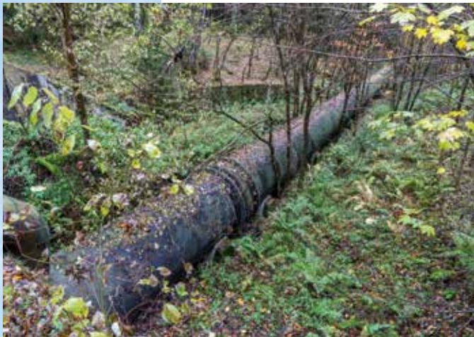
Více než 500 metrů dlouhé potrubí, kterým se přiváděla voda do vyšebrodské elektrárny. V horní části vodního přivaděče stojí domek pro pracovníka elektrárny
