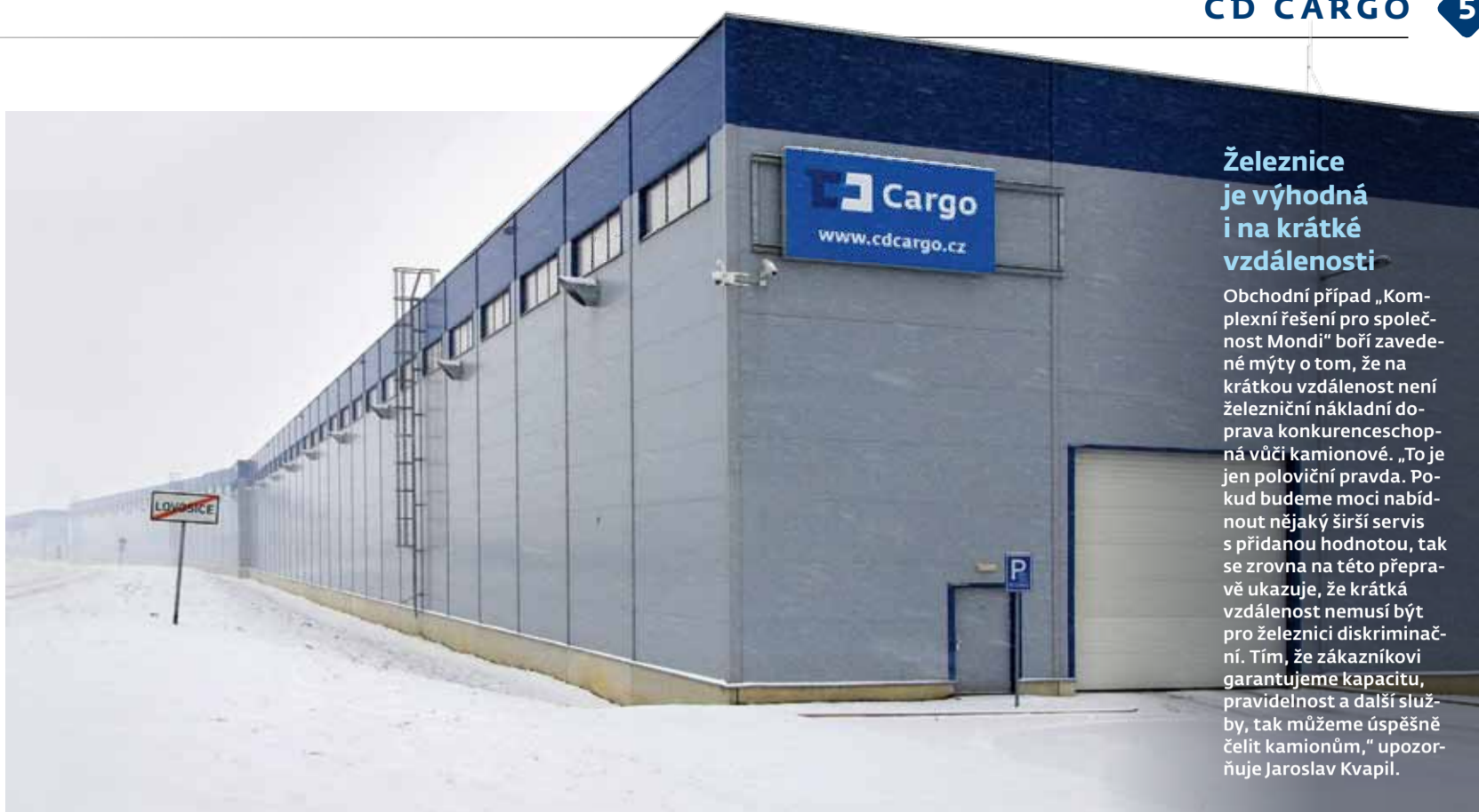
LOVOSICE. Moderní hala o kapacitě 42 500 m 2 , do které vede vlečka, byla zkolaudována v roce 2010.
