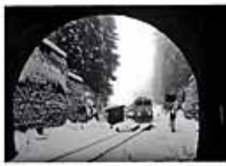
Až do roku 2007 byl Špičácký tunel nejdelší na naší železniční síti.
