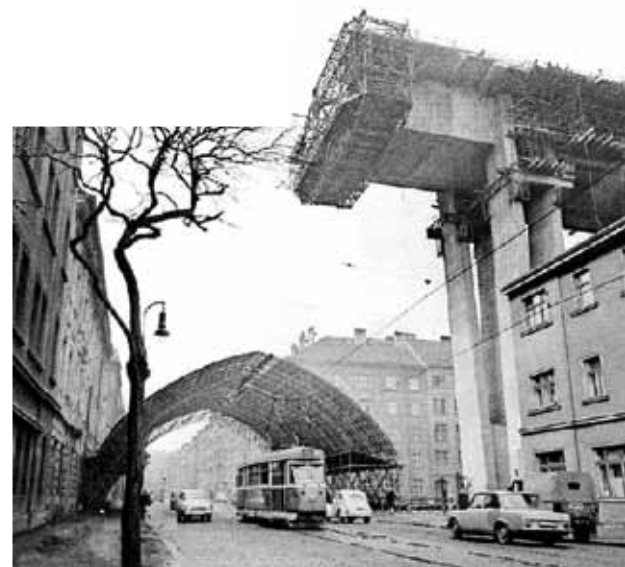
Během stavby mostu byly dotčené ulice i železniční trať překlenuty krycím obloukem.
