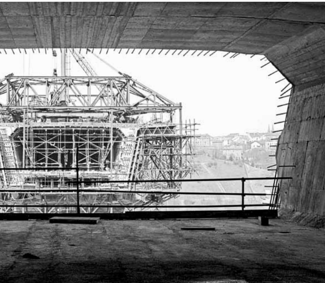
Snímek pocházející z 8. dubna roku 1969. Stavba byla v plném proudu. Na fotce je vnitřní tubus pro metro.
