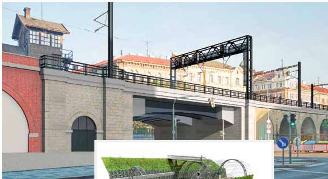
Negrelliho viadukt (SUDOP Praha)
