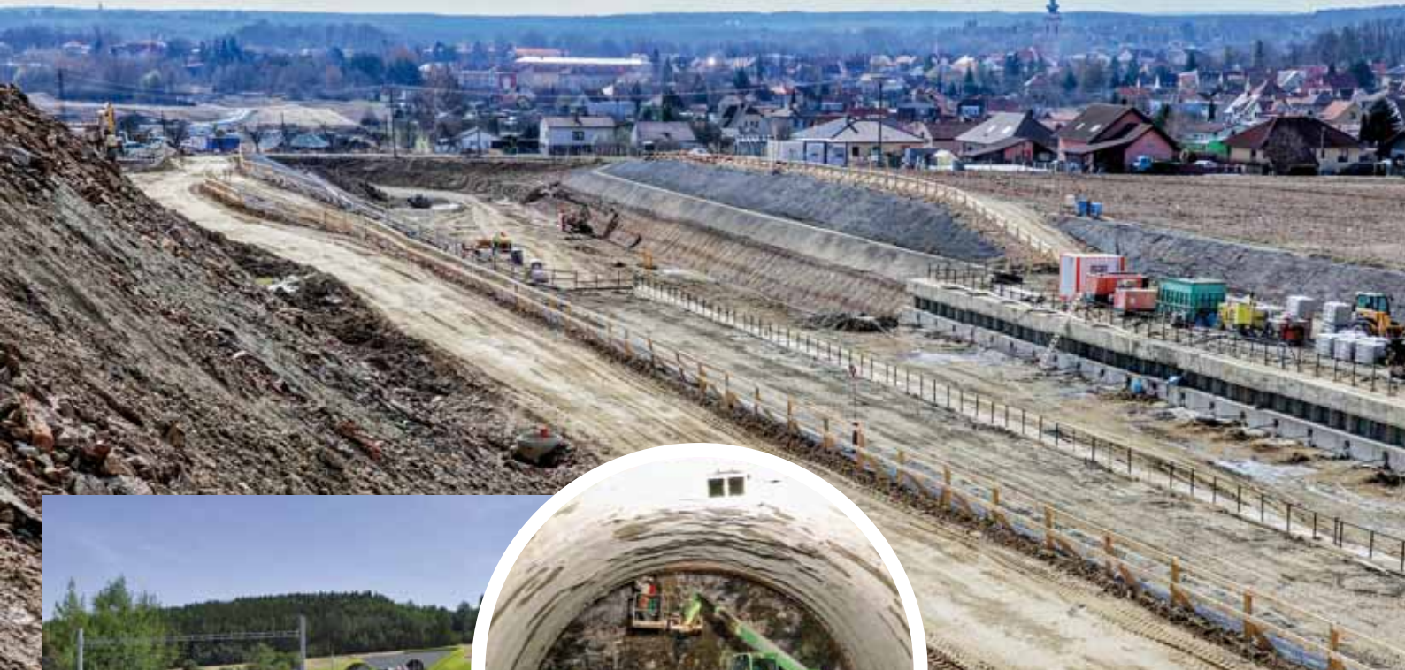
Staveniště Zvěrotického tunelu u Soběslavi
