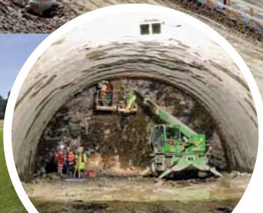
Tunel Mezno. Ostění se skládá z ocelové výztuže, příhradových oblouků a betonu.
