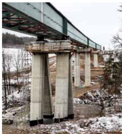
Aktuálně vzniká viadukt u Heřmaniček.
