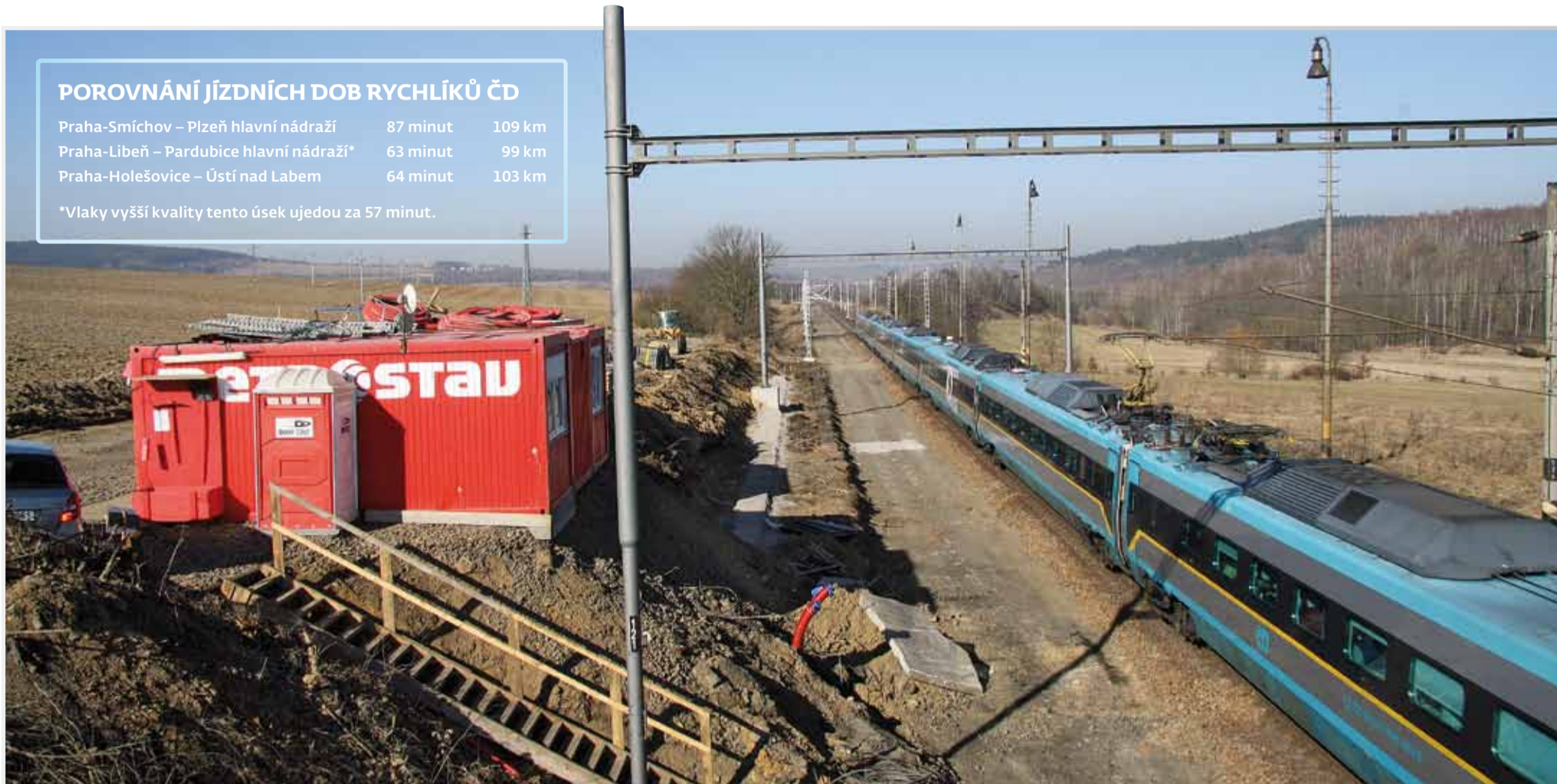
PO JEDNÉ KOLEJI. Stavbaři se aktuálně přesunuli na úsek Rokycany – Chrást u Plzně, takže vlaky tu musí jezdit pouze po jedné koleji. Vznikne zde mimo jiné nejdelší železniční tunel v republice. FOTO AUTOR
