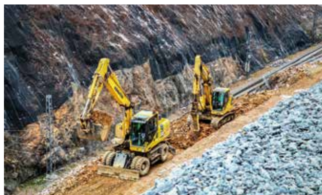
...zbytek zeminy odtěžila těžká technika. Kvůli zářezu vznikly přeložky silnic
