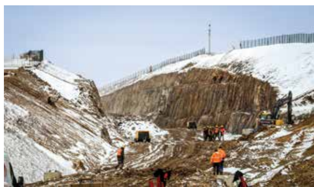
Zářez u Mezna. Skalní masiv museli stavaři odstřílet...
