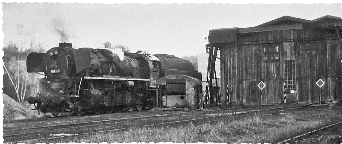
POJÍZDNÉ TEPLÁRNY. O vytápění budov depa v Lužné se staraly také tři vyřazené Štokry, na snímku z roku 1984 stroj 556.0238. FOTO AUTOR (3x)
