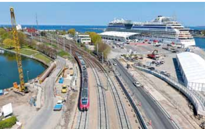
Stavební ruch během rekonstrukce stanice Warnemünde
