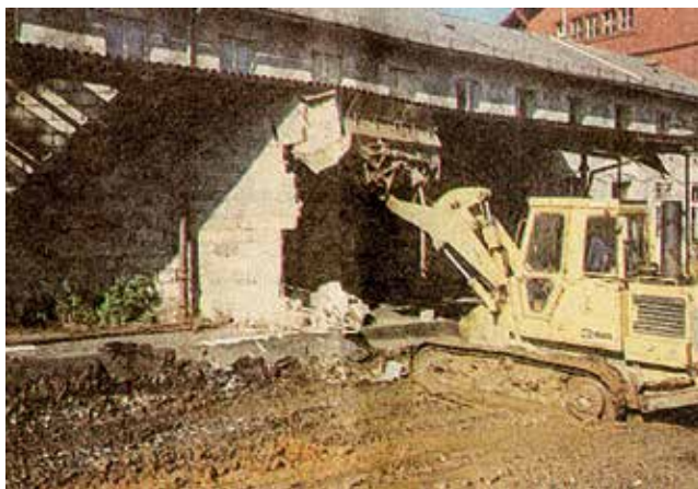
Demolice betonové zdi rozdělující státní hranici na alžbětínském nádraží
