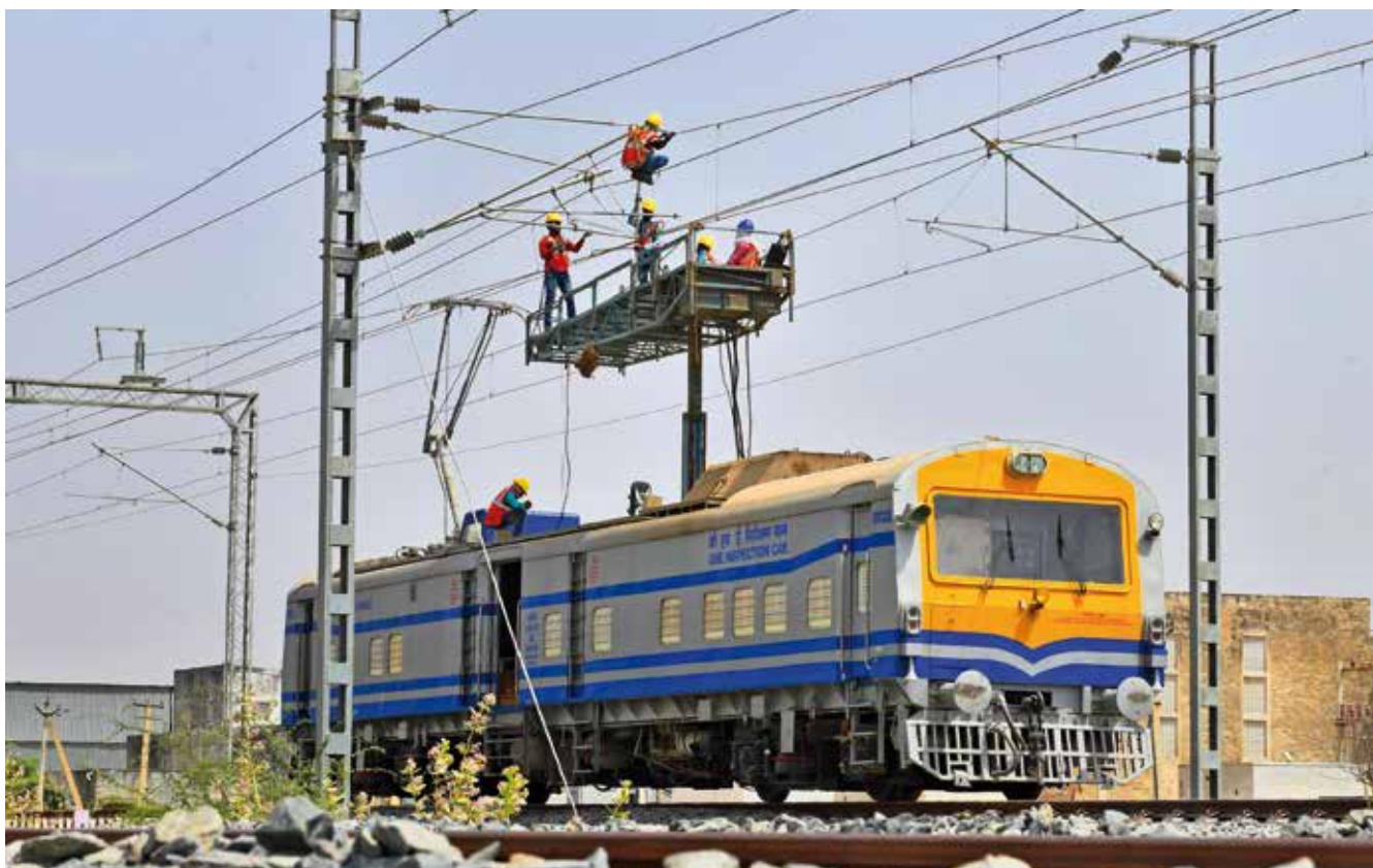
Dělníci testují elektrické dráty na železničním koridoru Dillí – Bombaj v Beawaru.
