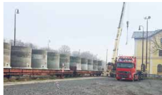
Překládka betonových skruží v Hostivici
