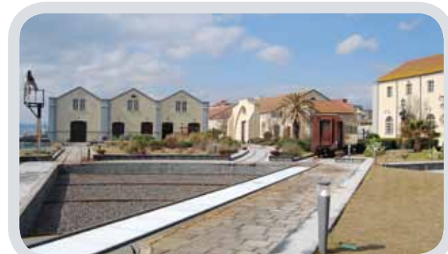
Přesuvna, návštěvnická, vodní jeřáb, ale i palmy nebo lavičky pro odpočinek vytvářejí nádvoří areálu.
