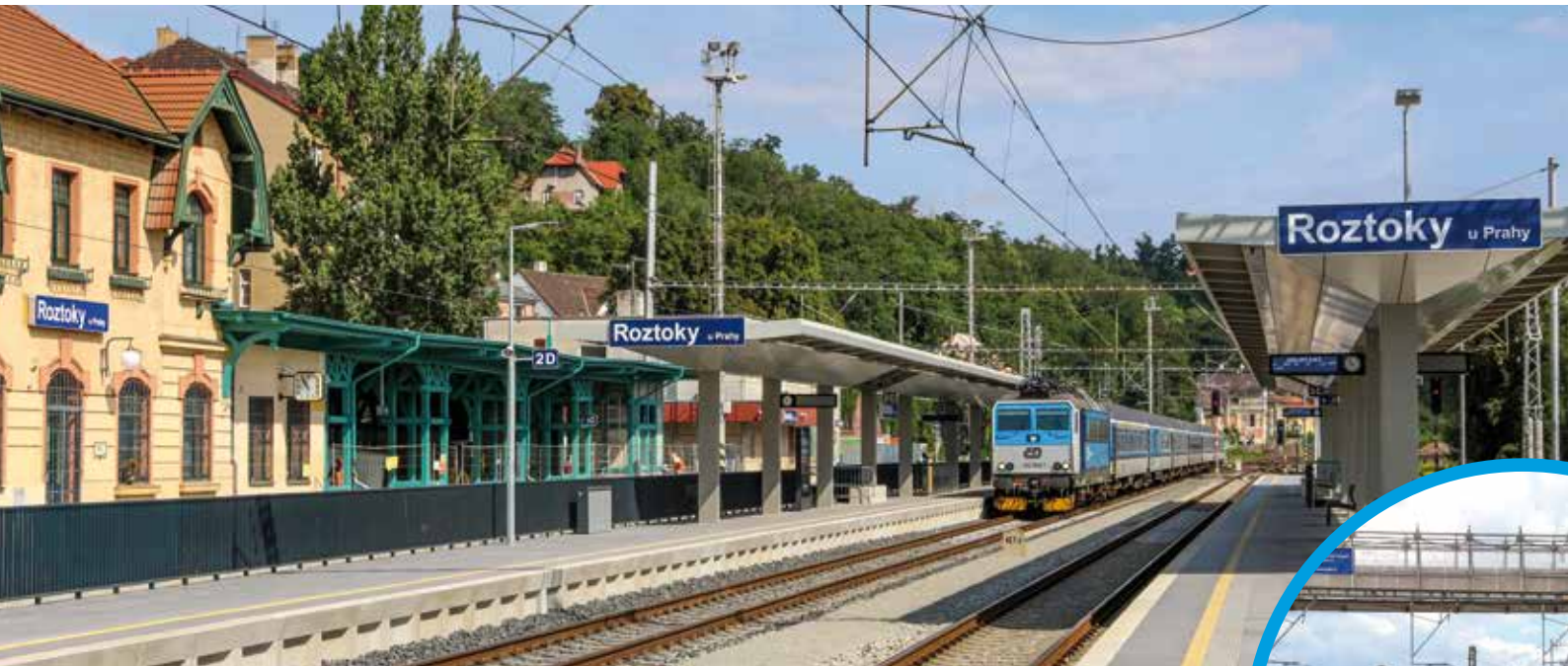
V Roztokách u Prahy vznikl oboustranně ústící podchod a čtyři bezbariérové nástupní hrany.
