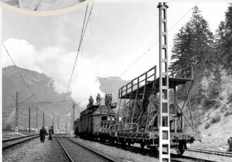
Dokončovací práce na elektrizaci trati Žilina–Spišská Nová Ves v květnu roku 1955
