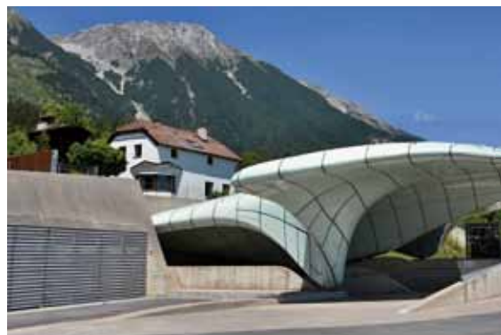
Horní stanice pozemní lanovky Hungerburg s nezaměnitelným rukopisem architektky Zahy Hadid
