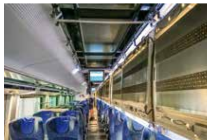
Záběr z instalace prvního opakovače v české jednotce railjet z letošního září
