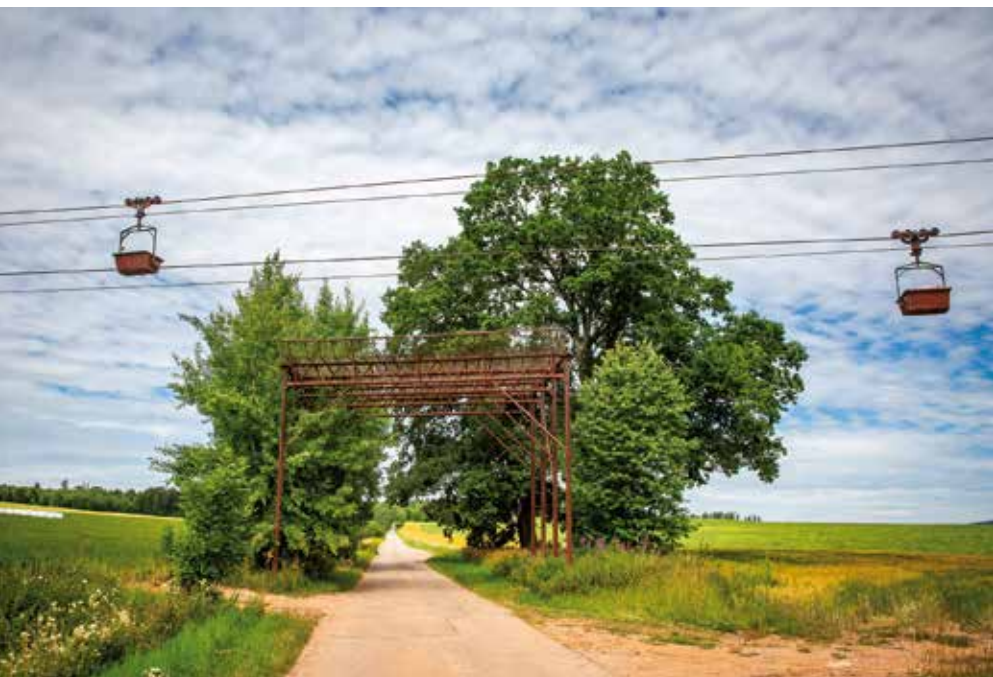
V místech, kde se dráha kříží se silnicí, stojí ocelové rámy schopné zachytit plně naložený vozík.
