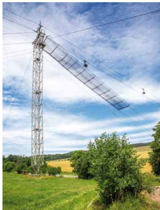
Nejvyšší stožár dráhy u silnice č. I/14
