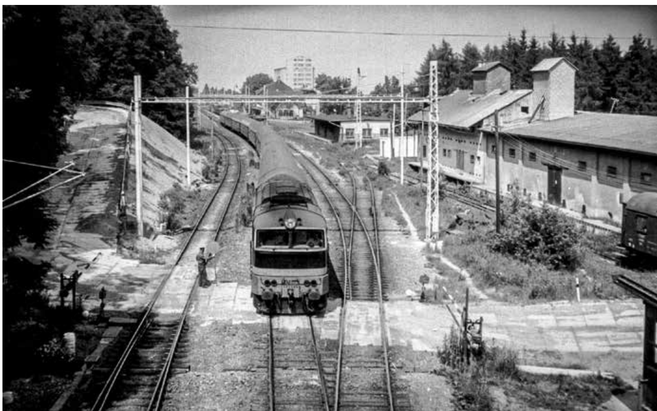
Na snímku z června roku 1986 je zachycen Břejlovec při průjezdu Voticemi v čele rychlíku Praha – České Budějovice. Vidět jsou i sloupky budoucího elektrického vedení. Závory a přejezd přes trať z betonových panelů jsou provizorní, sloužily pouze v době stavby elektrifikace. Železniční zaměstnanec na přejezdu drží ceduli s příkaznou jízdní rychlostí pro strojvedoucího
