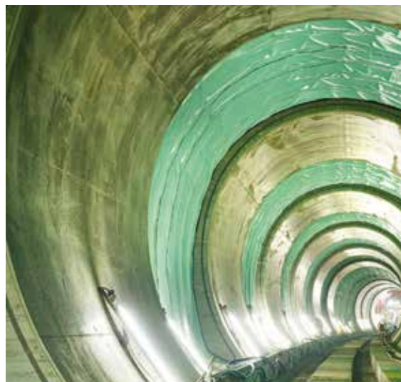
Tunel pod Semmeringem už místy spěje k dokončení.
