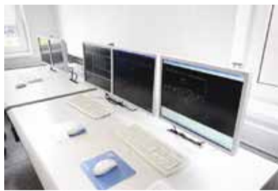
System ETCS je ovládán zabezpečovacím zařízením ESA 44.
