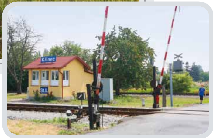
Křinecké mechanické závory kombinované s výstražníkem AŽD
