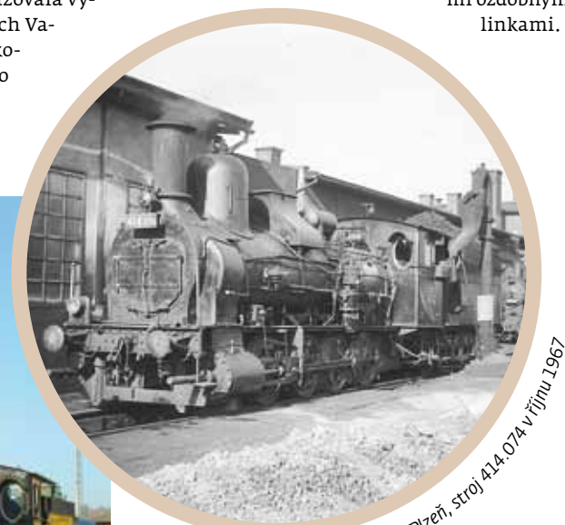
Poslední provozní Heligón depa Plzeň, stroj 414.074 v říjnu 1967
