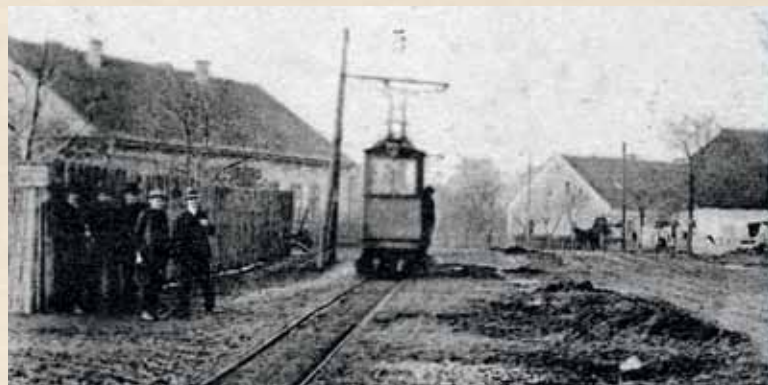
Dobový snímek bráské nákladní elektrické malodráhy dokazuje podobnost s průmyslovou elektrickou malodráhou v severočeském Jablonci, která tam fungovala dlouhá desetiletí i jako městská veřejná tramvajová trať.
