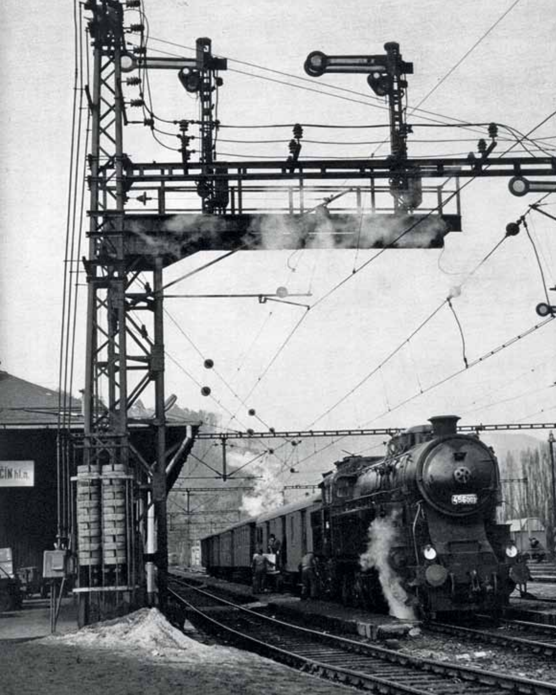
Hlavní nádraží v Děčíně v březnu roku 1969. Téměř 100 let neslo název Bodenbach či Podmokly. Za povšimnutí stojí, jako vzpomínka na 2. světovou válku, návěstidla (semafory) s ramenem opatřeným na svém konci podle zvyklostí Deutsche Reichsbahn (Německá říšská dráha) kruhovým terčem. Naši železničáři jim říkali Henlajny (podle K. Henleina – vůdce Sudetoněmecké strany) a ještě v roce 2016 jich kupodivu několik sloužilo na našich tratích.
