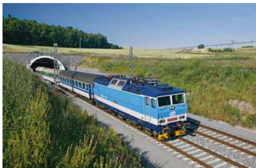
MODERNIZACE. Výstavba koridoru pokračovala v poslední době především mezi Bečovem a Táborem. Potrvá ještě přibližně pět let. FOTO 2M
