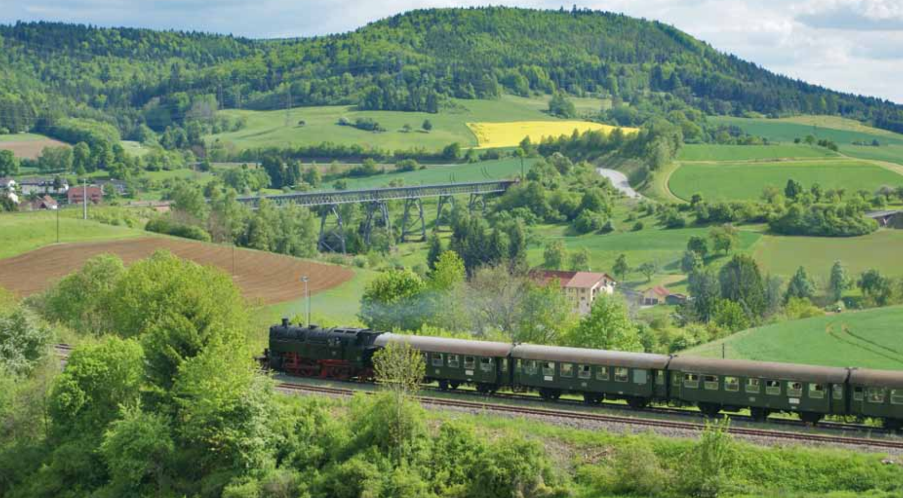
Obří viadukt Eppenhofen u stejnojmenného nádraží překlenuje celé údolí.
